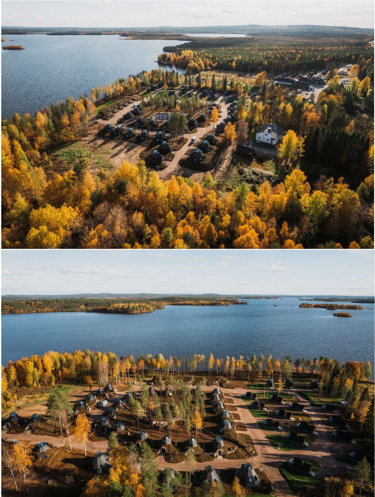
Kuva 16. Apukka Resortin rakennuksia VT 4 suunnalta.
